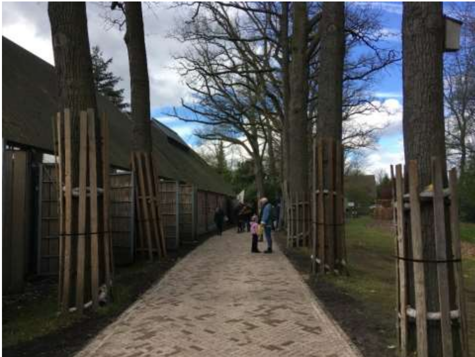
Aanleg bestrating februari 2022
